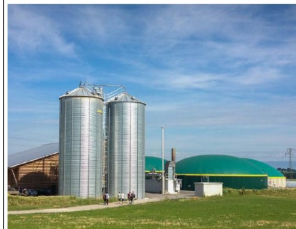
Biogasanlage Düdingen (FR)
