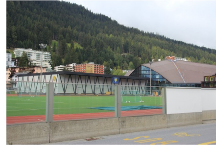
1. Trennwand Strasse-Sportplatz, 2. Trainingshalle HCD, 3. Vaillant Arena
